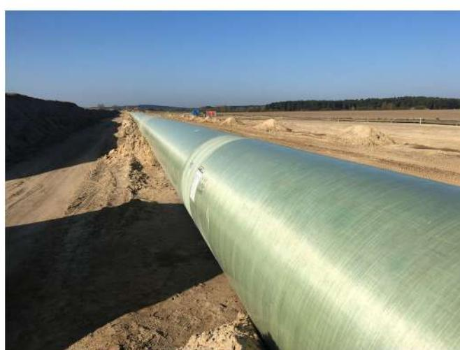
این شرکت افتخار دارد تا به عنوان همکار و نماینده فروش شرکت های تولیدی بنام، با بهره گیری از فناوری روز اروپا اقدام به تحويل انواع لوله و اتصالات GPR به روش الیاف پیچی پیوسته از قطر ۳۰۰ الی ۲۶۰۰ میلیمتر نماید. لوله های مذکور با طول های ۱۲ و ۶ متر، فشار کاری ۱ تا ۳۲ بار و درجه سختی تا ۱۲۵۰۰ پاسکال مطابق با استانداردهای ASTM D۲۵۶۳، ASTM ۲۹۹۲، ASTM ۲۴۱۲، ASTM ۳۵۶۷ و درخواست مشتریان قابل عرضه است.
